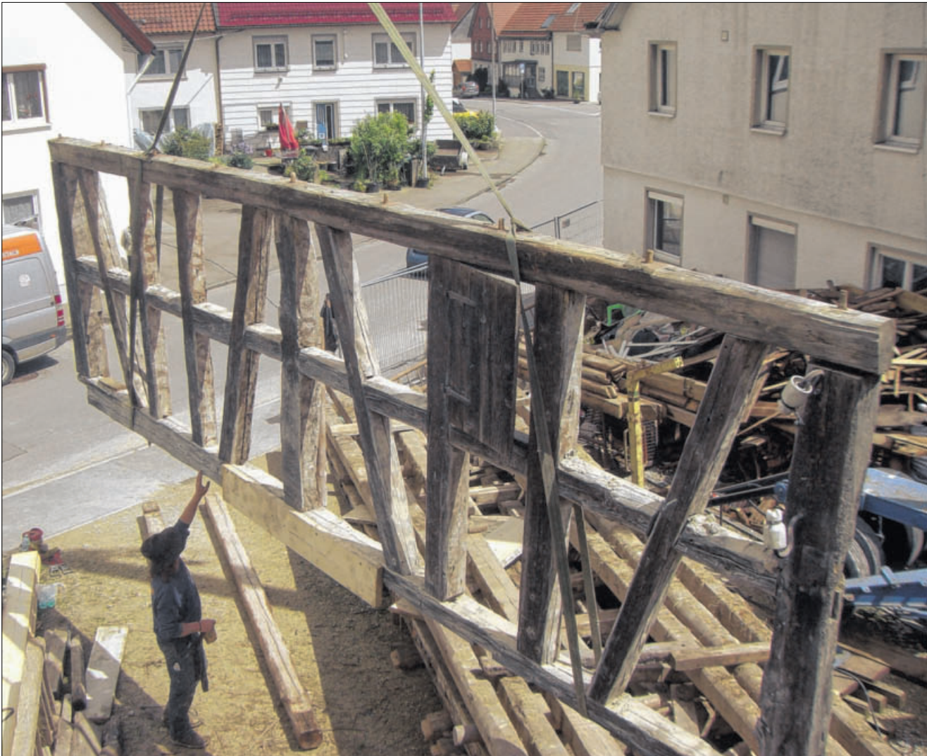
Massenweise Holz auf der Abrissstelle im Ortskern von Laichingen: Aus dem Baumaterial soll ein neues Wohngebäude entstehen. Auf manchen Balken finden sich noch alte Beschriftungen (rechts oben). Martin Häberle (rechts unten), Inhaber der Firma „historische Baustoffe Ostalb“, ging mit einem Kran zu Werke.
